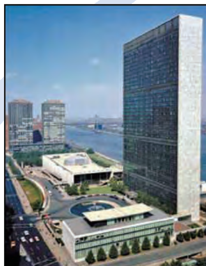
国連本部の敷地に選ばれた場所。41番街のチューダー・シティ(住宅用ビル)から北に48番街を眺めた景色(左)。ニューヨーク市の同じ場所にある現在の国連本部ビル(上)。
